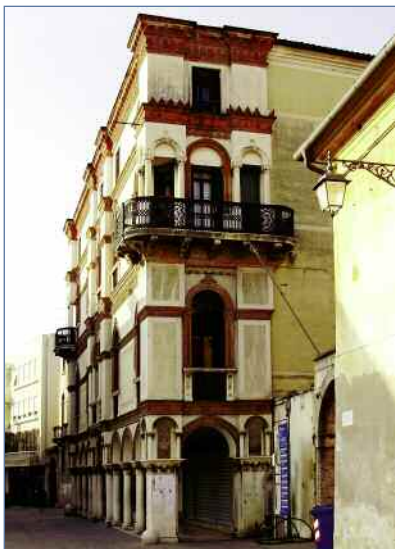
Via Jacopo da Ponte, Palazzo Vinanti sede dell'omonimo collegio.
